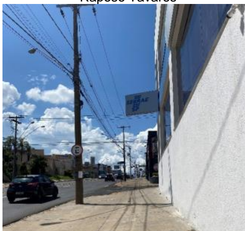
Figura 3.24: Fachadas impermeáveis próxima ao cruzamento com a Rua Raposo Tavares
