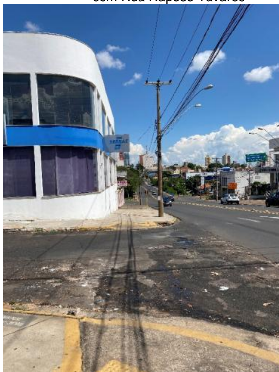
Figura 3.16: Irregularidades e ausência da faixa de pedestres no cruzamento com Rua Raposo Tavares
