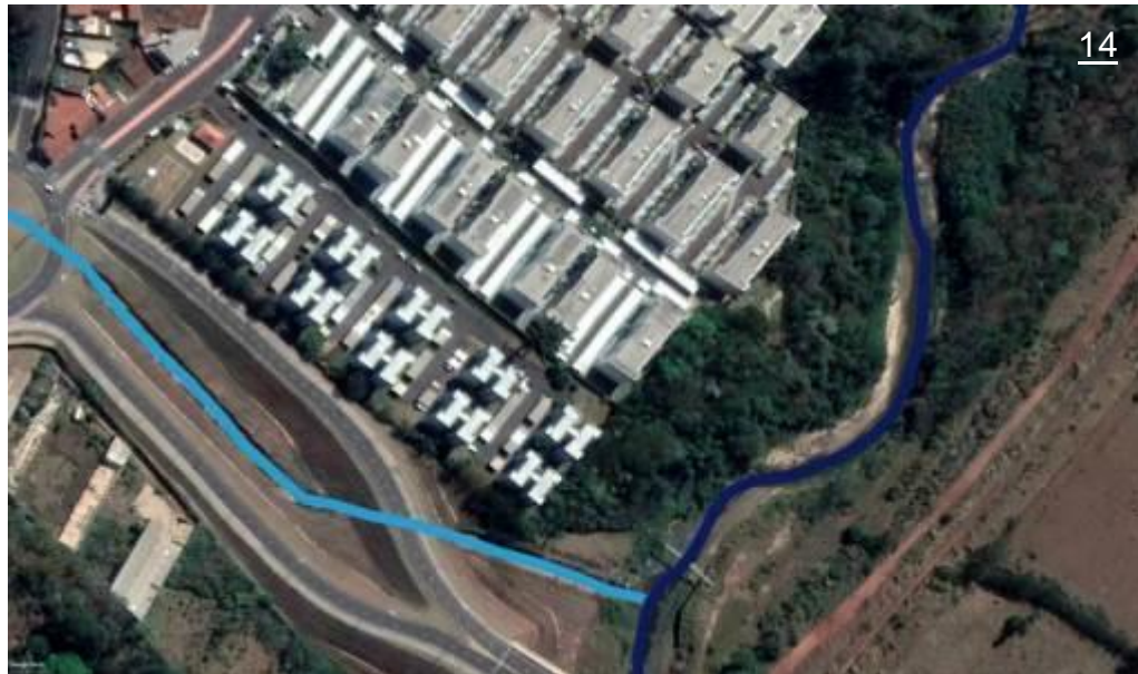
Figura 72– Ampliação 14: Erosão e desmatamento no entorno do Rio Lavapés
