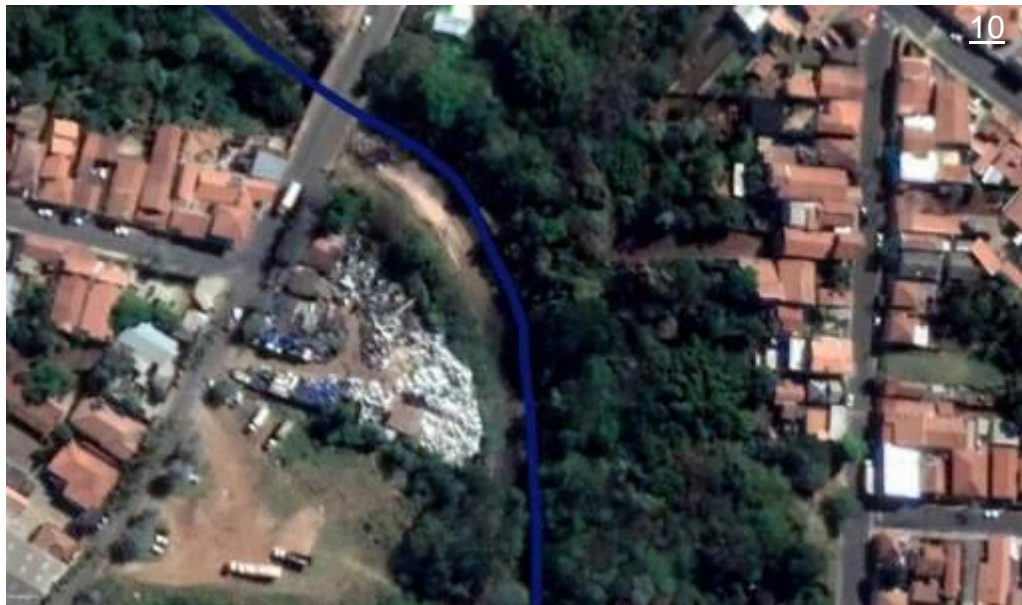
Figura 68– Ampliação 10: Lixo e erosão no entorno do Rio Lavapés
