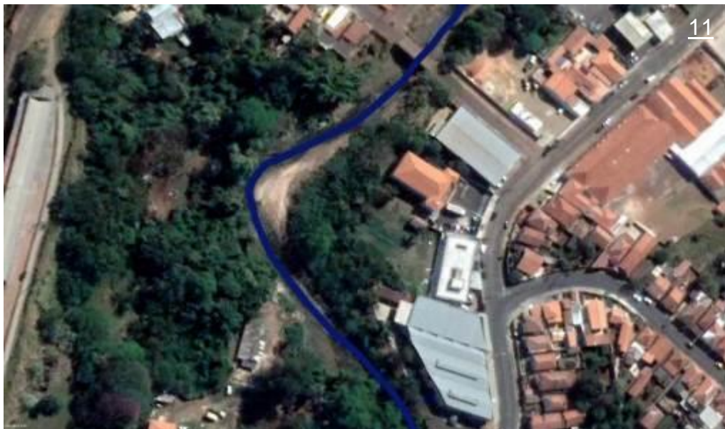
Figura 69– Ampliação 11: Erosão e ocupação irregular no entorno do Rio Lavapés
