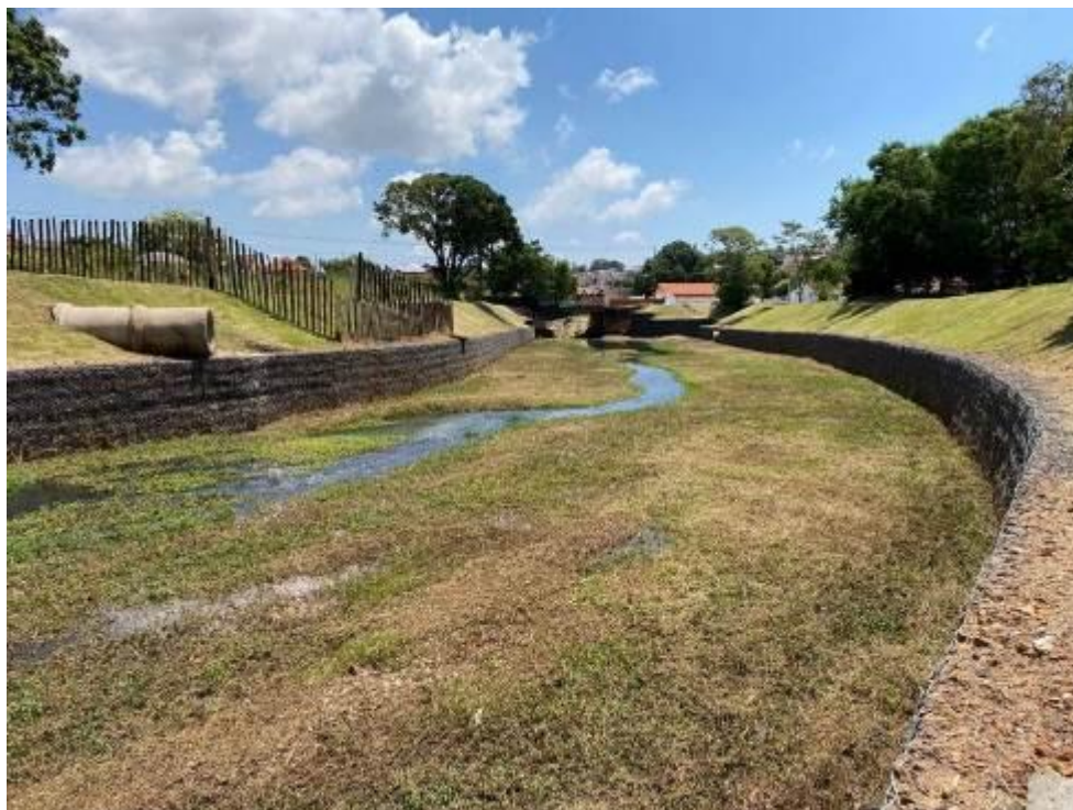
Figura 76– Muro de gabião e alargamento do Rio Lavapés
