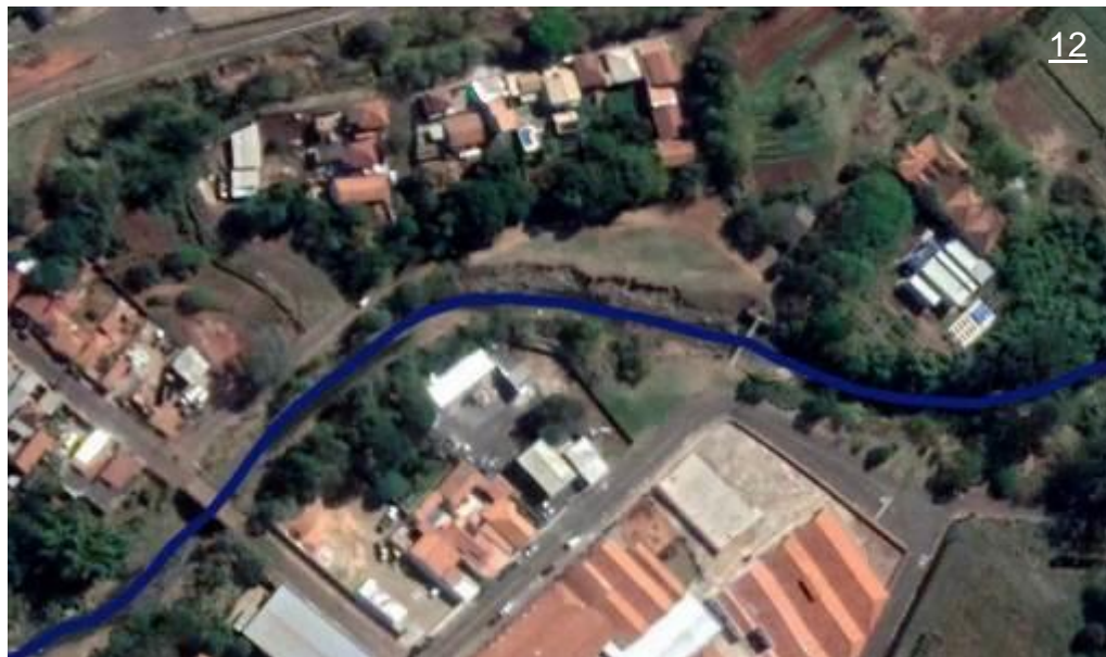
Figura 70– Ampliação 12: Erosão, desmatamento e ocupação irregular no entorno do Rio Lavapés
