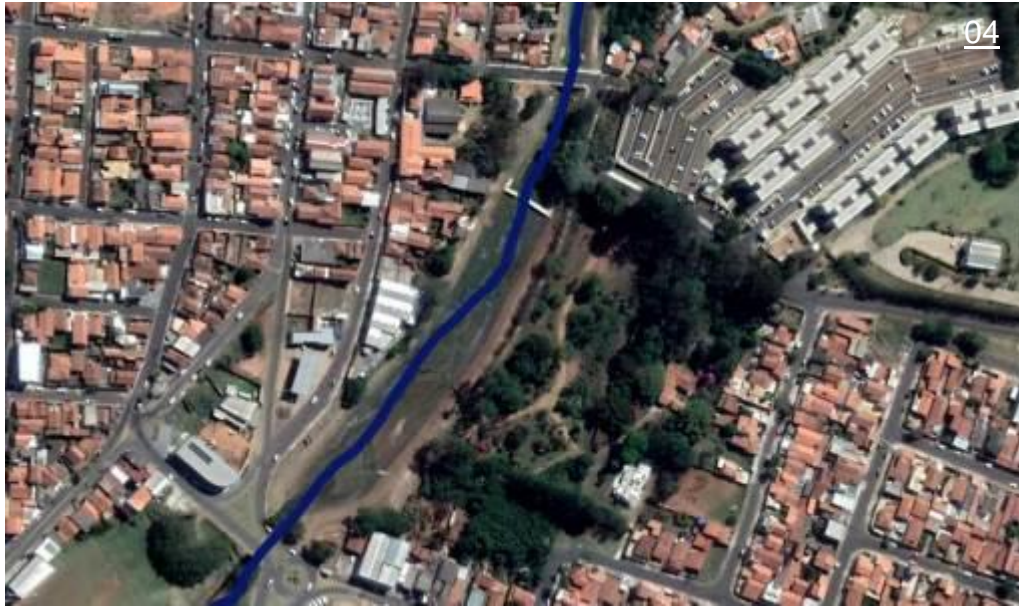
Figura 62– Ampliação 04: Desmatamento e ocupação irregular no entorno do Rio Lavapés
