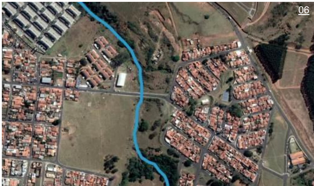
Figura 64– Ampliação 06: Desmatamento e erosão no entorno do Rio Lavapés
