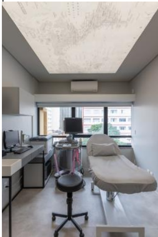
Figura 19: Sala de ultrassom com luz controlada com dimer no teto com tela tensionada plástica e translúcida.
