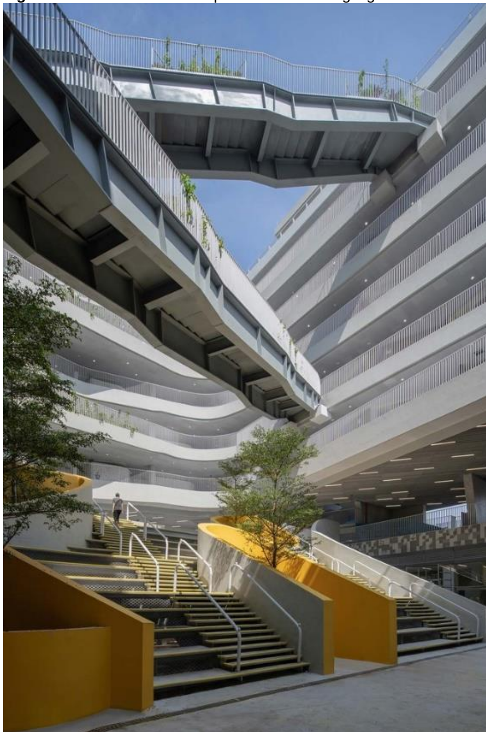
Figura 30. Escola Primária Experimental de Hongling. Estrutura de Aço
