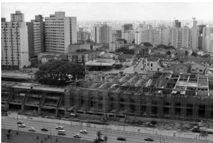
Figura 21 - Etapa de Construção do Centro Cultural São Paulo
