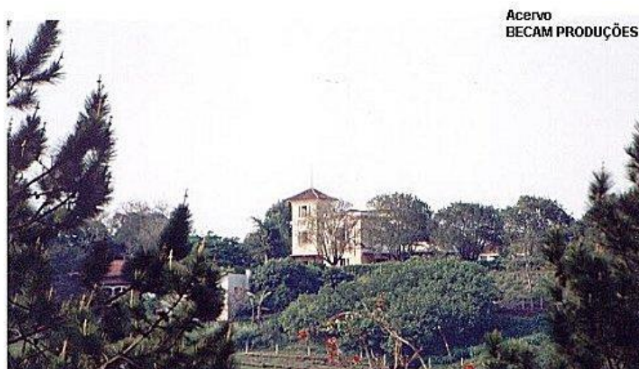
Figura 48 - Vista Horizontal da Estação de Piraju
