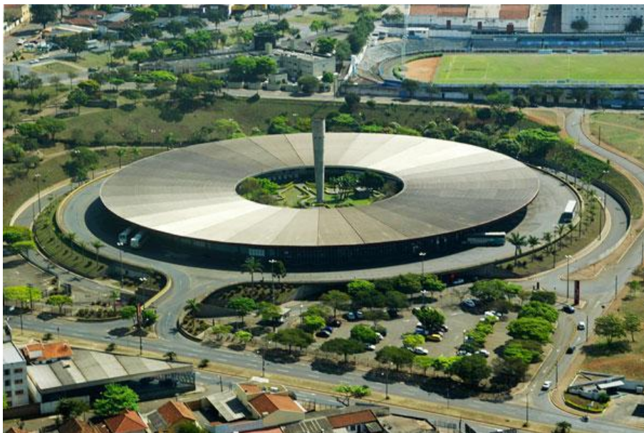
Figura 5 - Terminal Rodoviário de Londrina
