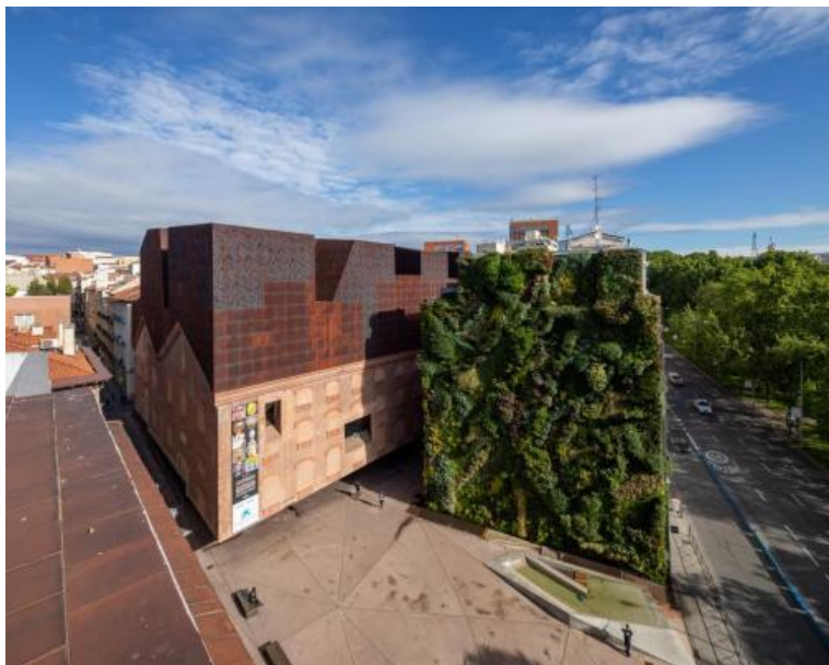
Figura 40 - Jardim Vertical do Edifício CaixaForum
