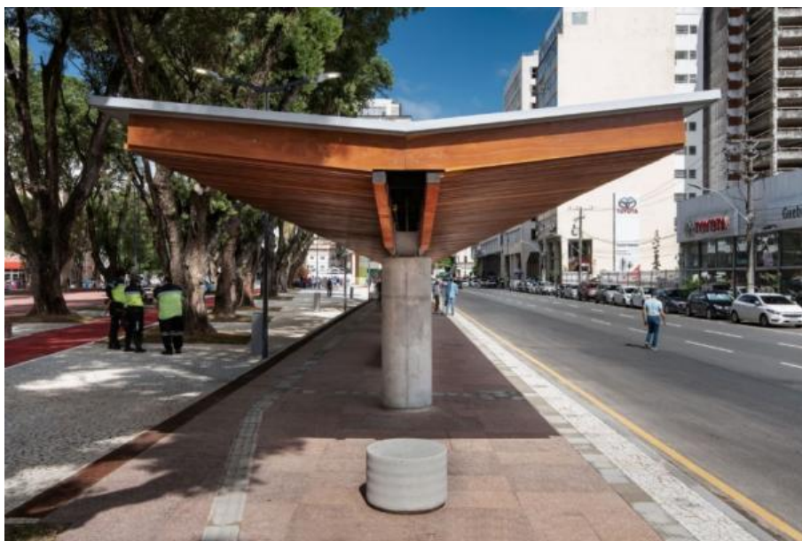
Figura 16 - Vista Lateral do Ponto de Ônibus da Praça
