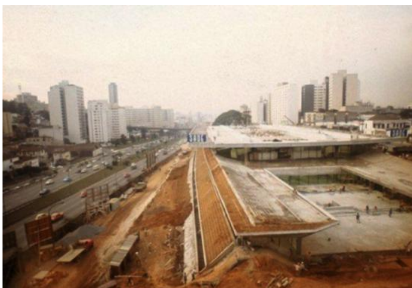
Figura 26 - Etapa Construtiva Tomando Forma
