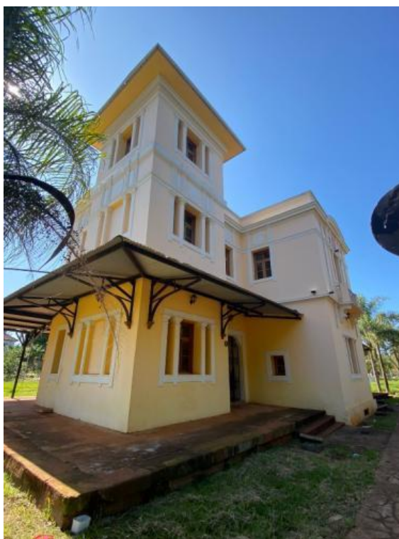
Figura 65 - Antiga Estação Ferroviária de Piraju
