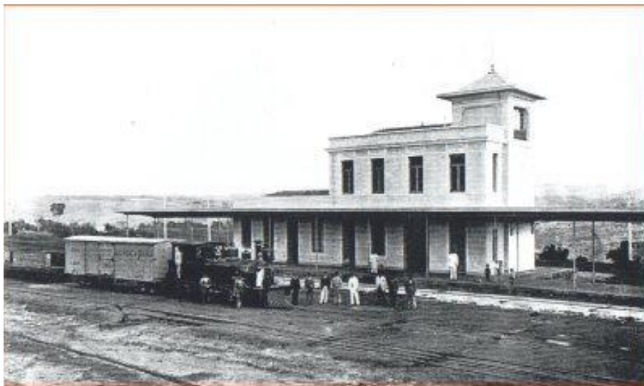
Figura 43 - Ramal Ferroviário de Piraju
