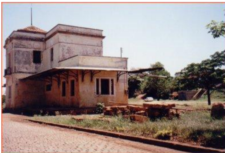
Figura 47 – Antiga Estação Ferroviária de Piraju
