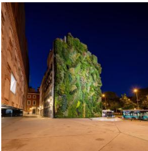
Figura 39 - Jardim Vertical do Edifício CaixaForum
