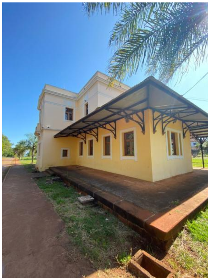
Figura 50 - Foto Vista Pedestre da Estação Ferroviária de Piraju
