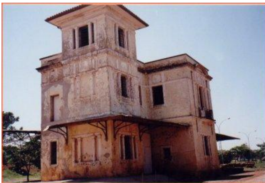
Figura 46 - Antiga Estação Ferroviária de Piraju
