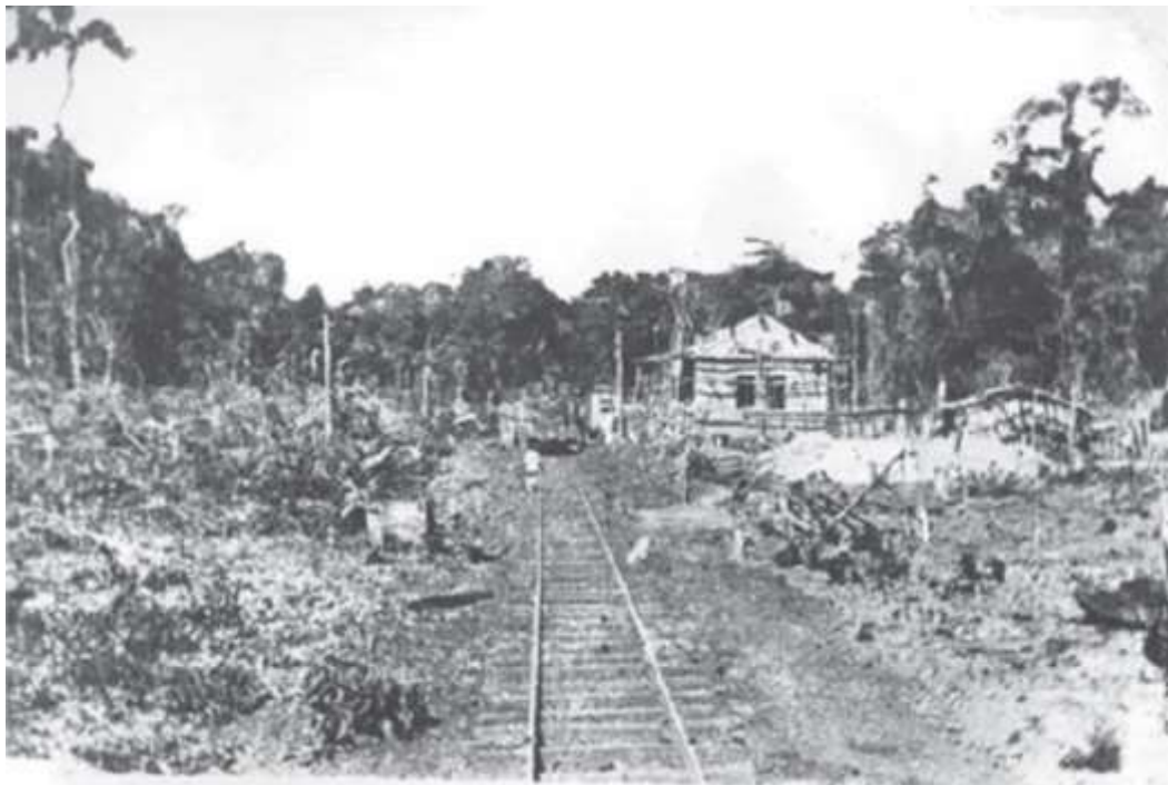
Figura 45 - Construção de estação da Noroeste em mata fechada
