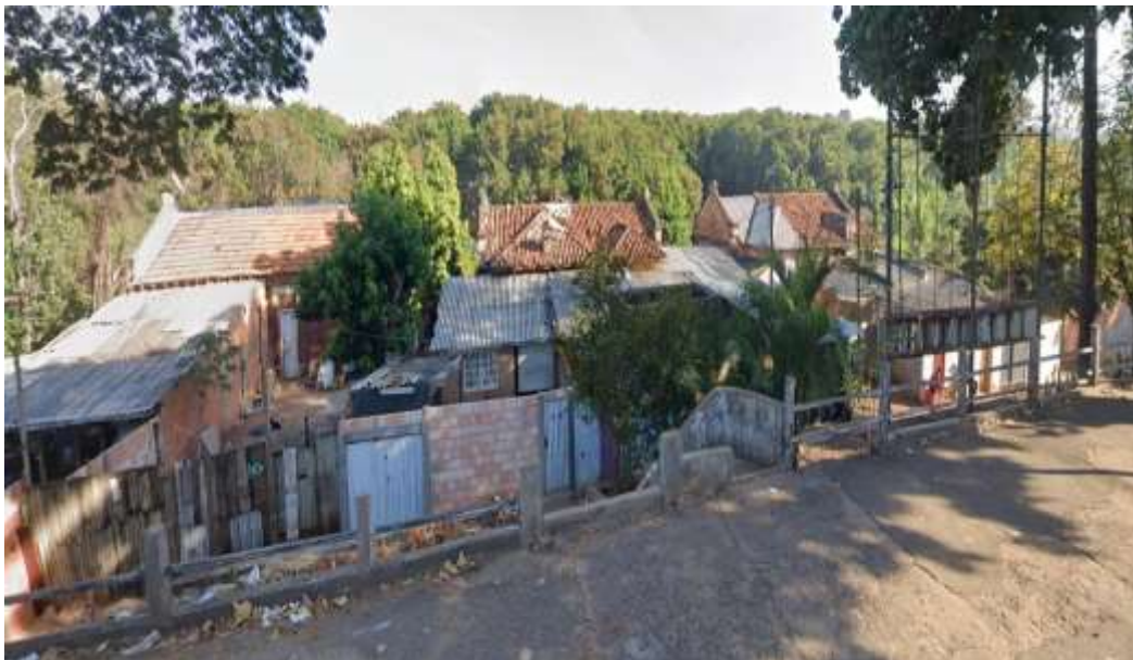
Figura 48 - Ocupação irregular na antiga vila de funcionários da ferrovia
