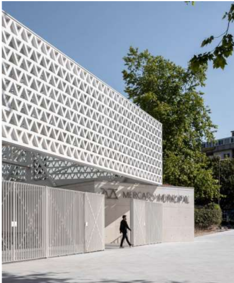
Figura 13 - Vista externa da estrutura metálica vazada
