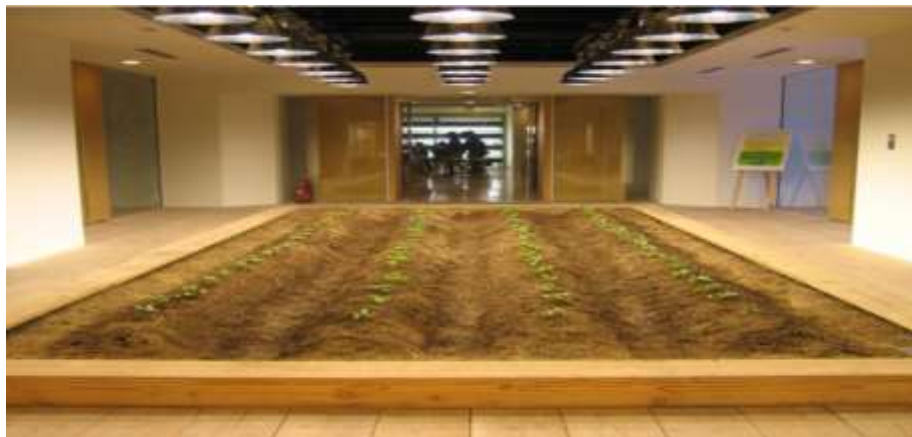
Figura 32 - Luminárias de teto instaladas no alinhamento inferior das vigas
