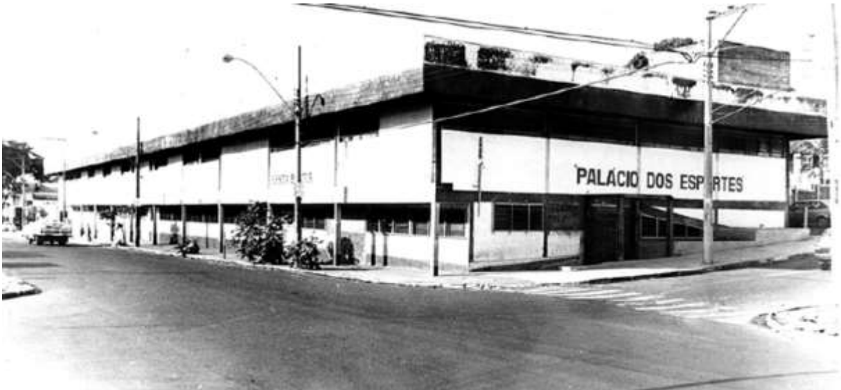
Figura 52 - Edifício do antigo Mercado Municipal de Bauru, já em funcionamento como Palácio dos esportes
