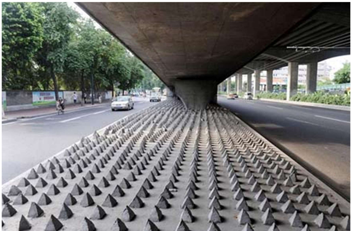
Figura 7 - Viaduto com obstáculos
