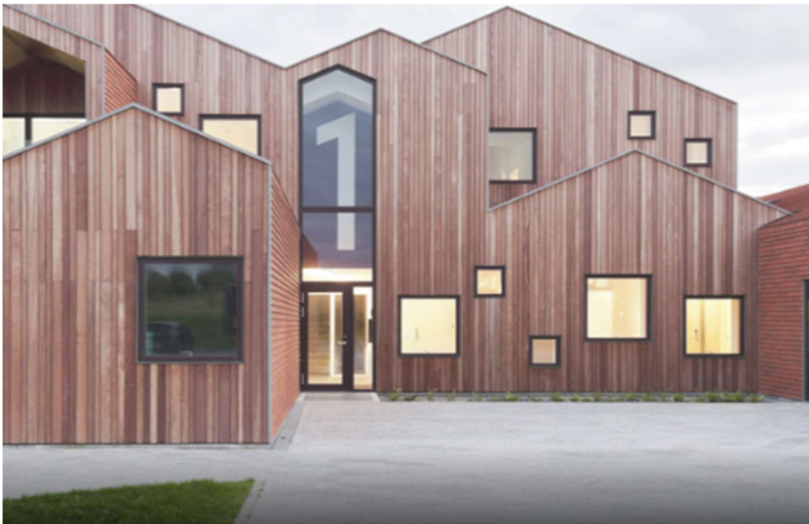
Figura 21 - Casa de Acolhimento para Menores - Vista externa frontal
