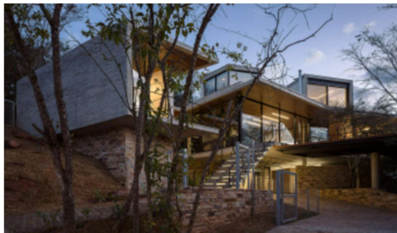
Figura 31: A angulação para o leste e a empena cega de concreto
