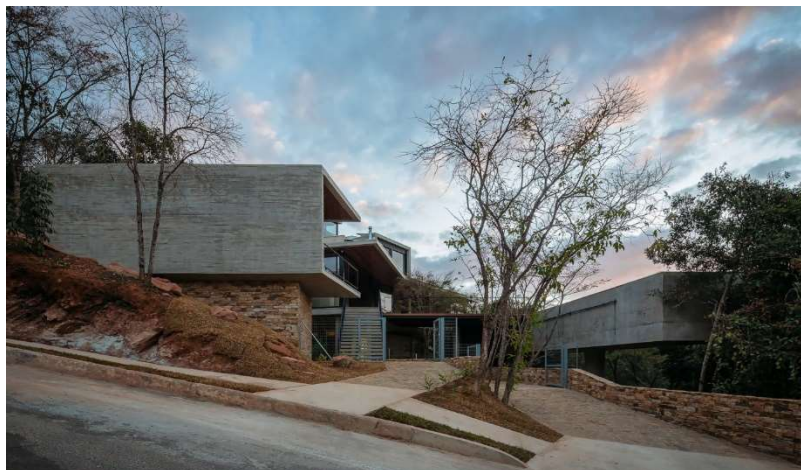
Figura 28: O declive acentuado do terreno e os volumes encaixados de forma suave
